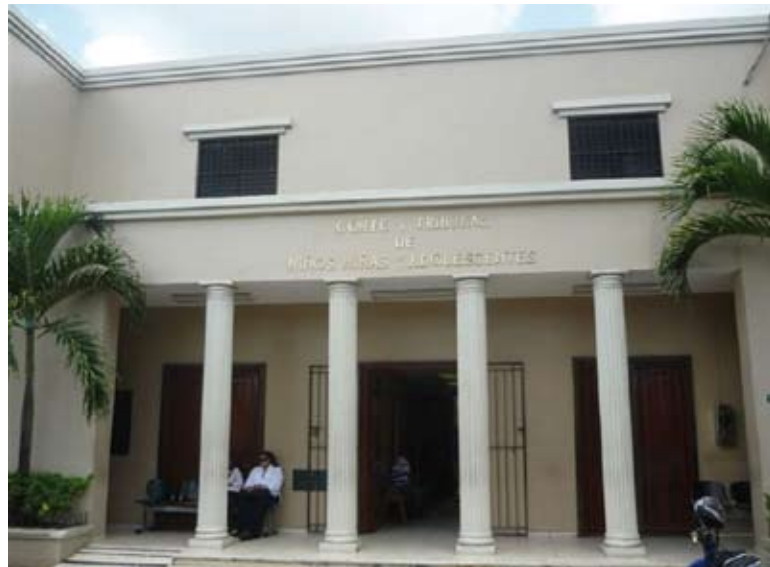
Vista parcial del Edificio de la Jurisdicción de Niños, Niñas y Adolescentes del Distrito Nacional.
