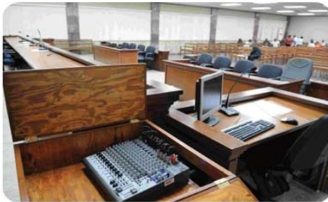
Sistema de Captura de Audio instalado en la Sala de Audiencias
