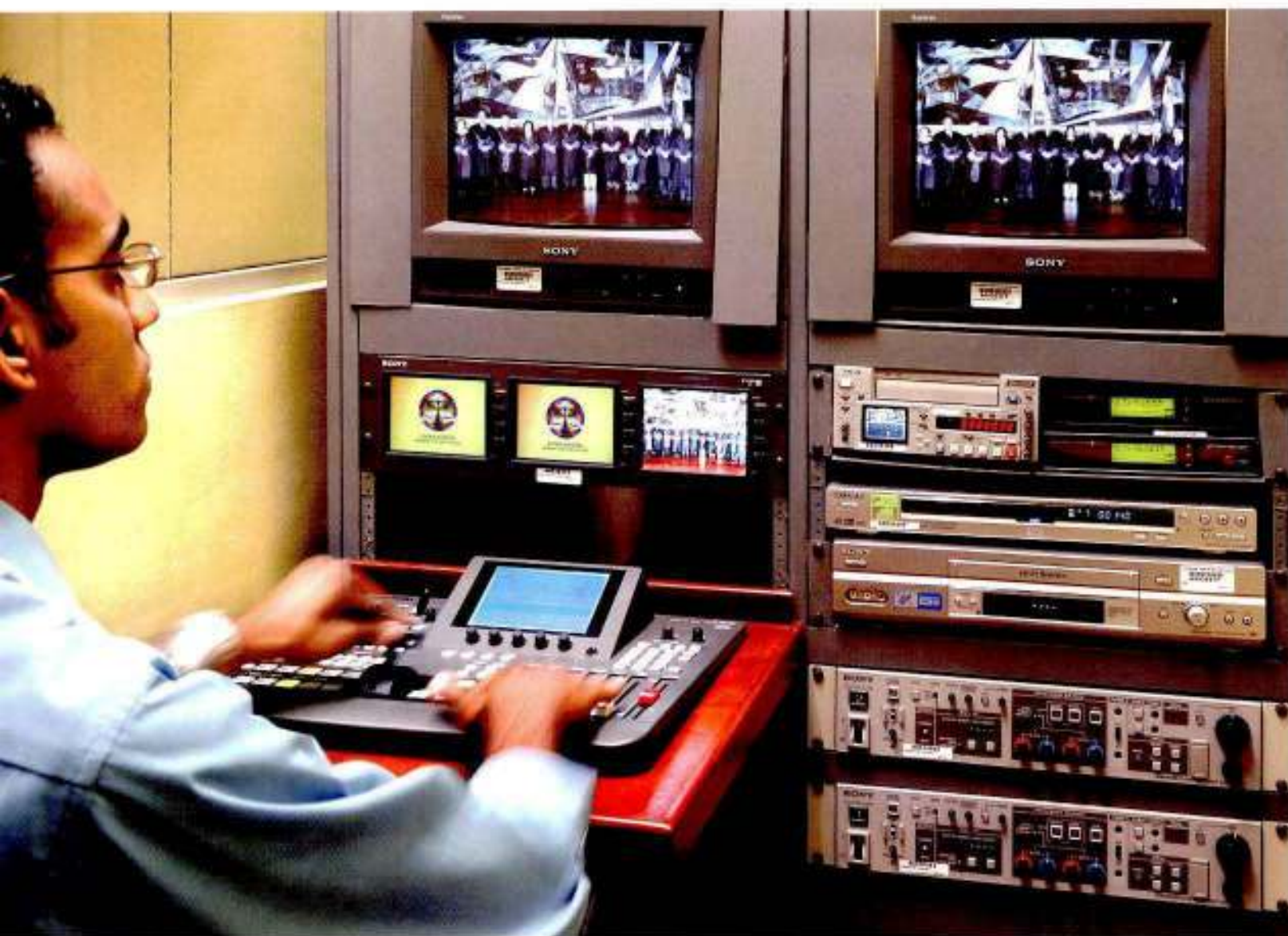
Cuarto de Control de la Sala de Prensa, cuarto nivel.
