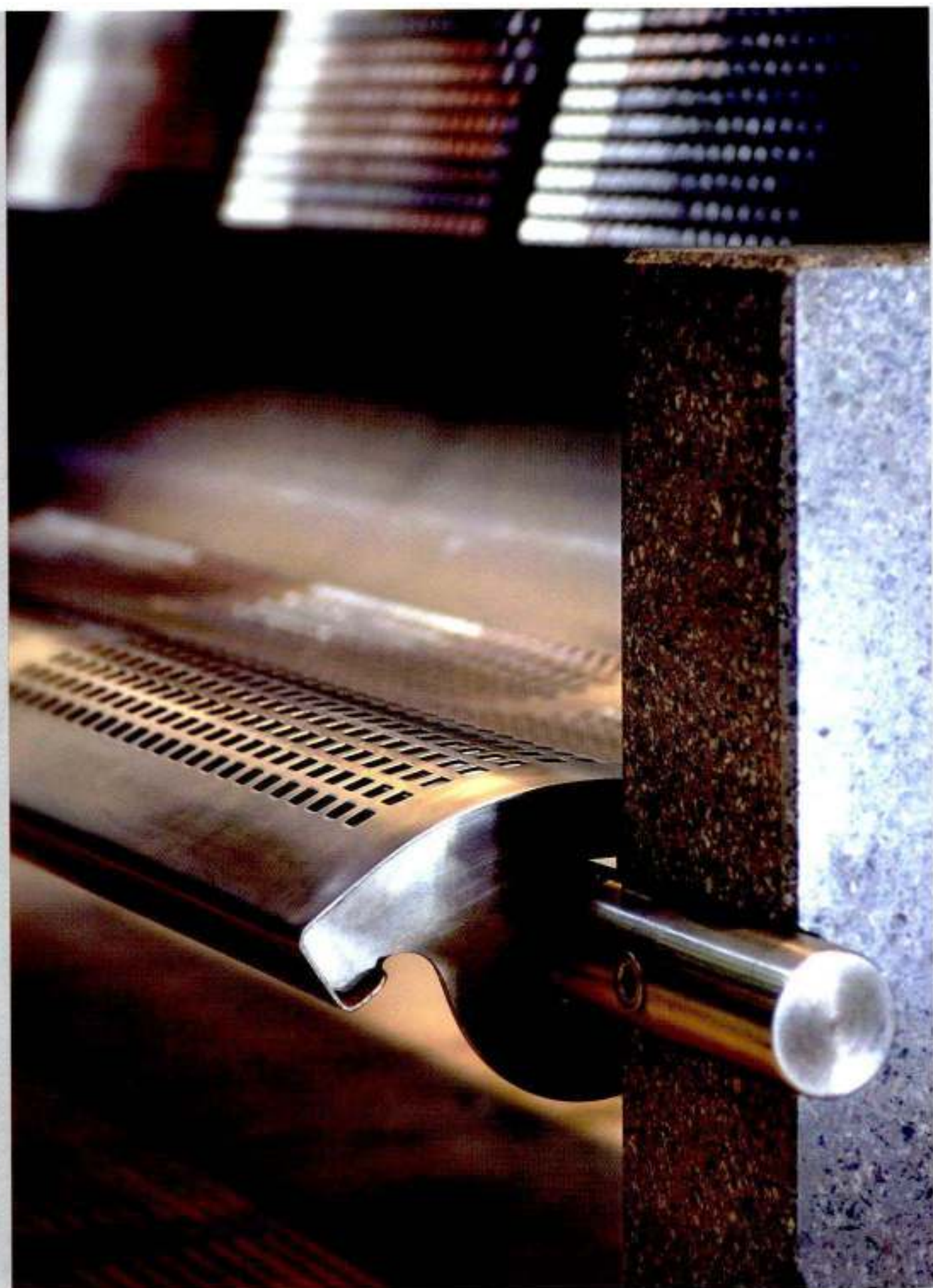
Detalles donde se destaca la utilización de materiales como el acero inoxidable, mármol y hormigón estructural.
