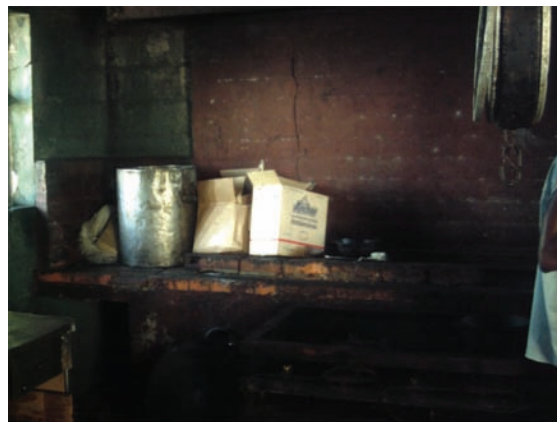
Cocina de la Cárcel Santa Rosa de Lima
